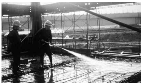
・ 建設工事現場での床洗浄に...
